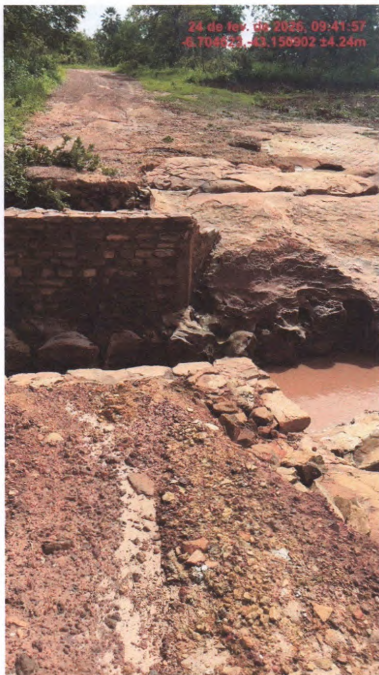
Figura 1: Localização da ponte
